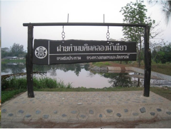
ฝายทำนบดินคลองน้ำเขียว
